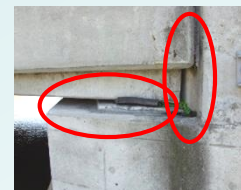
支承交換や桁端点検の空間なし
