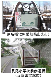
通行止め橋梁
