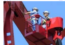
直轄診断(三島大橋)
