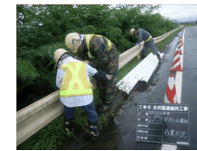
＜防護柵の取替＞
