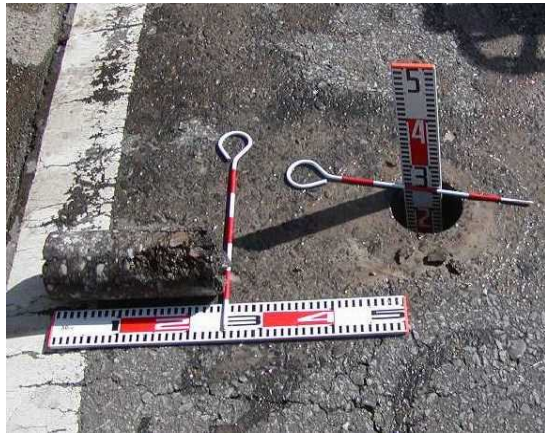
(アスファルト舗装におけるコア抜き調査の実施例)
