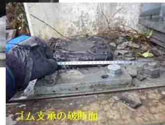
写真-2 ゴム支承の破断
