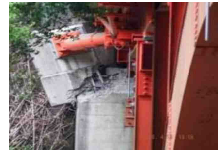
写真-5 県道熊本高森線・大切畑大橋におけるゴム支承の損傷（左） と国道325号・南阿蘇橋におけるダンパー取付部の損傷（右）
