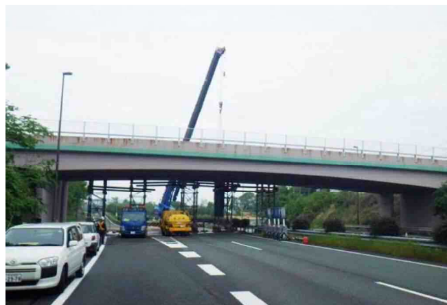
写真-1 橋梁概観
