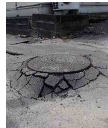
写真-13 電柱の沈下やマンホールの浮き上がり及び周辺地盤の沈下 (左:町道・熊本市南区近見地先、右:町道・熊本県益城町寺迫地先)
