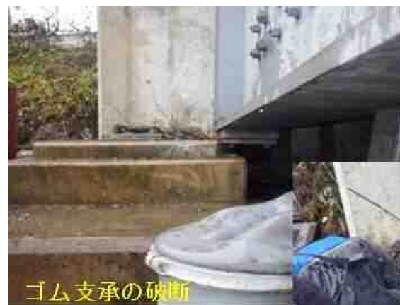
写真-2 ゴム支承の破断
