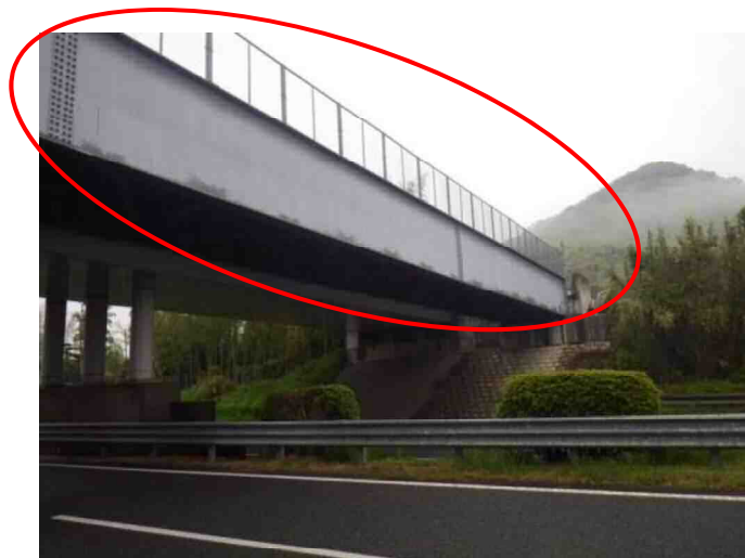
写真-1 橋梁概観
