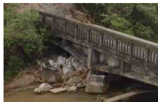
写真-2 平田・小柳線 田中橋
