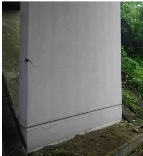
写真-2 橋脚の損傷
