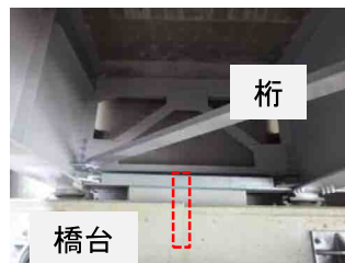
写真-5 アンカーバー のイメージ
