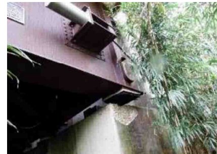
写真-5 県道熊本高森線・大切畑大橋におけるゴム支承の損傷（左） と国道325号・南阿蘇橋におけるダンパー取付部の損傷（右）
