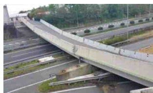
写真-1 県道小川嘉島線 府領第一橋
