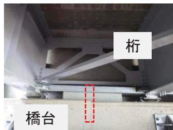
写真-5 アンカーバーのイメージ
