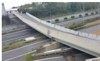
写真-1 県道小川嘉島線 府領第一橋
