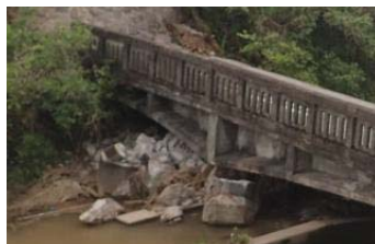
写真-2 平田・小柳線 田中橋
