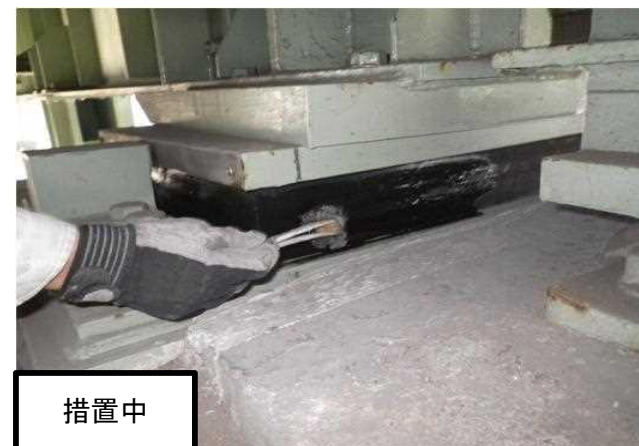
ゴム支承劣化予防措置
