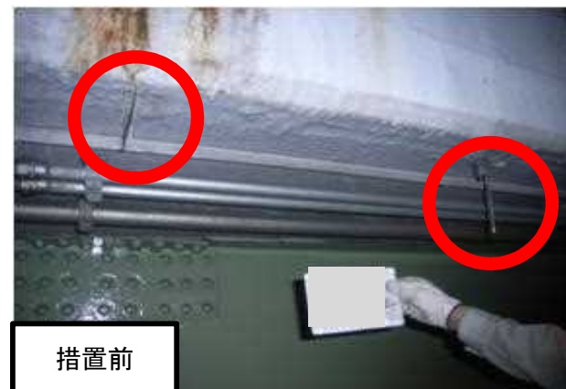
遊離石灰(つらら)除去
