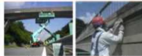
点検実施状況
