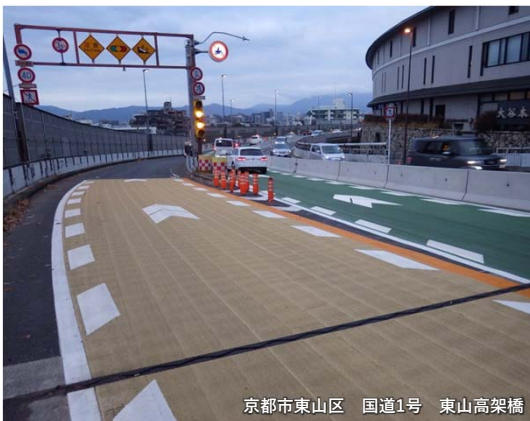
京都市東山区 国道1号 東山高架橋
