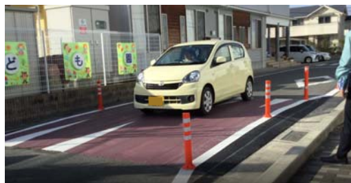
本設ハンプ設置状況
