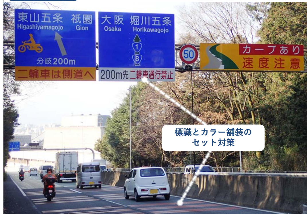
京都市東山区 国道1号 東山高架橋 平成29年2月完了
