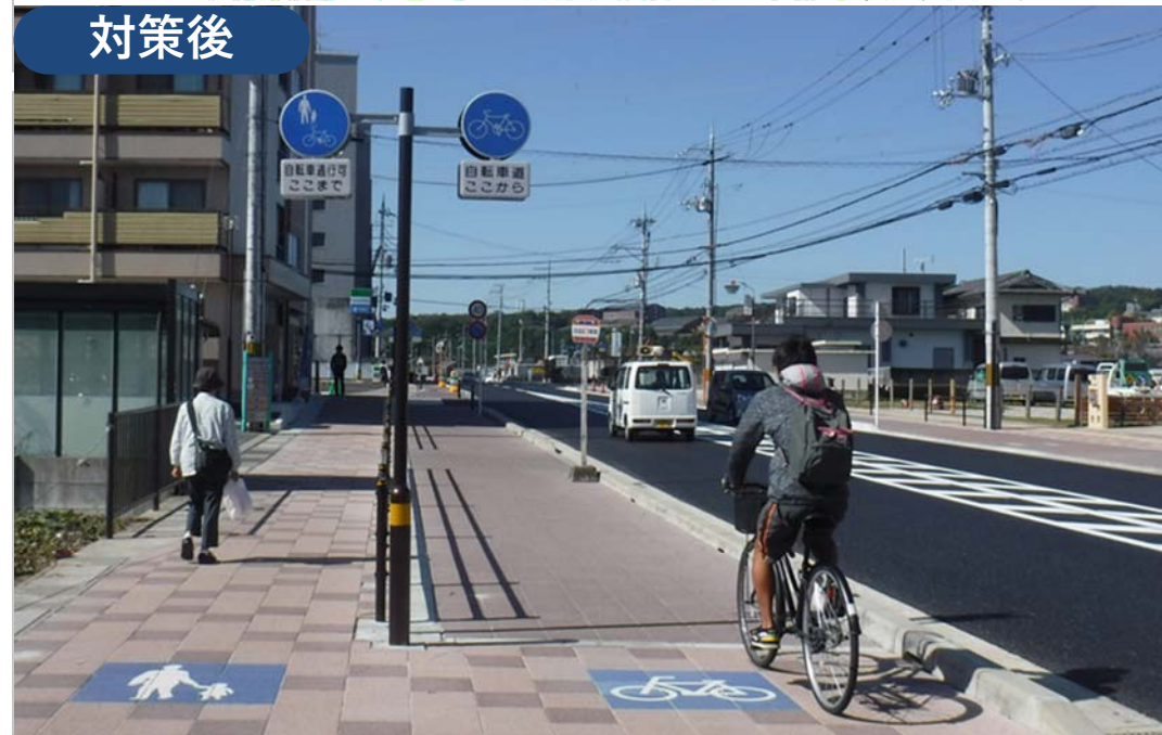
京田辺市三山木 生駒井手線 平成28年10月完了
