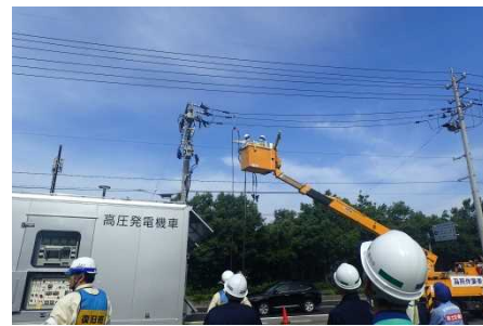
電源供給訓練(北陸電力)
