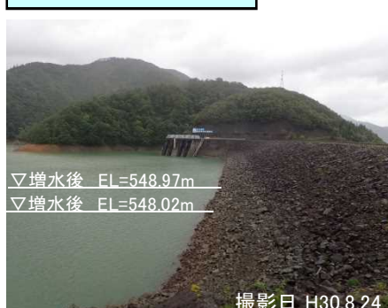
状況写真(九頭竜ダム)
