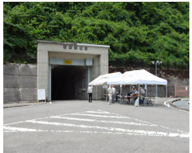
長野発電所会場
