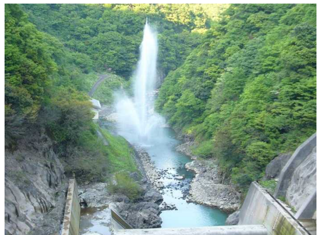
堤頂から下流を見る
