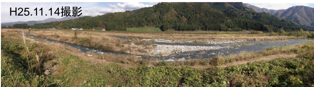
水際ほぐし施工箇所の状況
