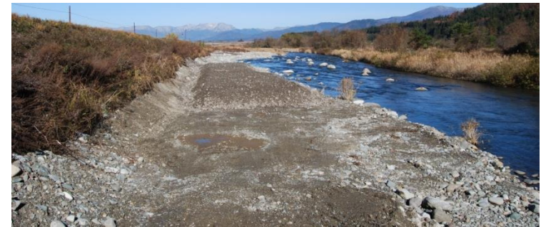
H25置土施工後(H24.12)撮影
