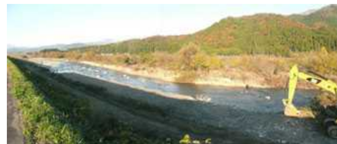
H24置土施工後 (H23.11) 撮影
