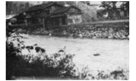
旧大野郡和泉村板倉付近(写真出典:九頭竜川流域誌) 九頭竜川右岸の深掘れにより、崩れ落ちそうな民家。
