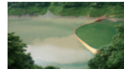
可動式汚濁防止フェンスを設置
