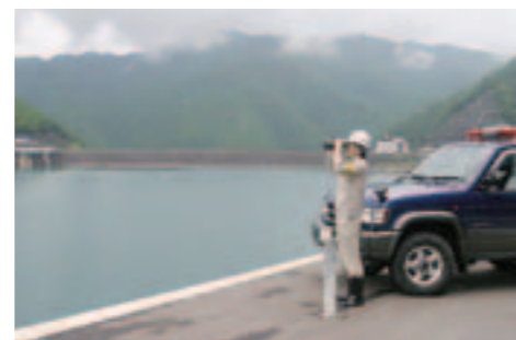
ダム湖の巡視状況
