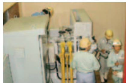
電気設備の点検状況
