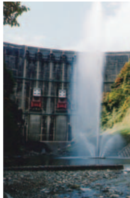
水環境改善事業で整備を行った噴水施設
