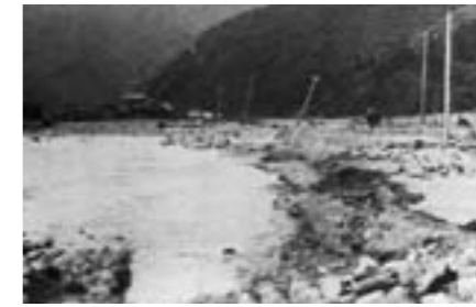
旧大野郡和泉村朝日付近(写真出典:九頭竜川流域誌) 九頭竜川右岸が決壊し、国道158号を跡形もない程に押し流しました。(電柱の立っている場所が元国道)
