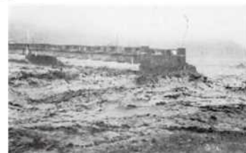
大野市佐間付近(写真出典:九頭竜川流域誌) 真名川の増水により、佐間橋は左岸取付部より破壊流失しました。
