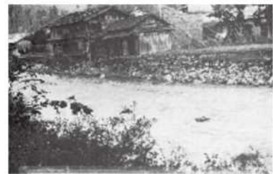
旧大野郡和泉村板倉付近(写真出典：九頭竜川流域誌) 九頭竜川右岸の深掘れにより、崩れ落ちる家を。
