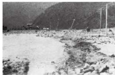
旧大野郡和泉村朝日付近(写真出典：九頭竜川流域誌) 九頭竜川右岸が決壊し、国道158号を崩形もない程に押し流しました。 (電柱の立っている場所が元国道)
