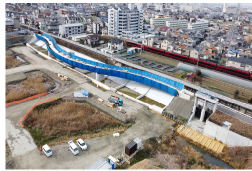
法善寺多目的遊水地 管理用道路橋梁工事
