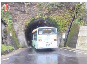
① 幅員が狭く、すれ違いが不可能なトンネル
