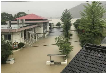
2018年7月豪雨の被害状況
