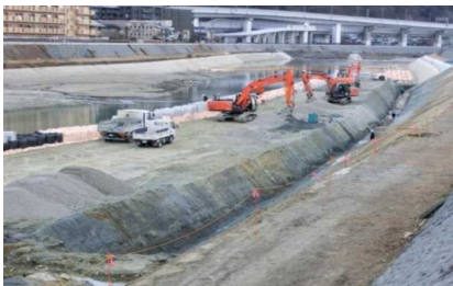
出在家地区河道掘削(猪名川)
