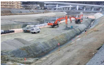
出在家地区河道掘削(猪名川)
