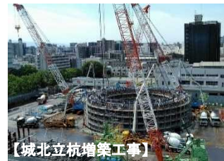
【城北立坑増築工事】
