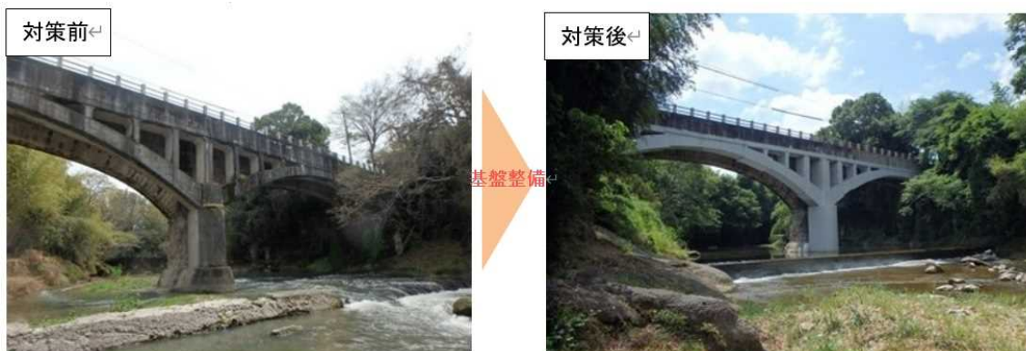
御坂サイフォン水路橋の耐震対策
