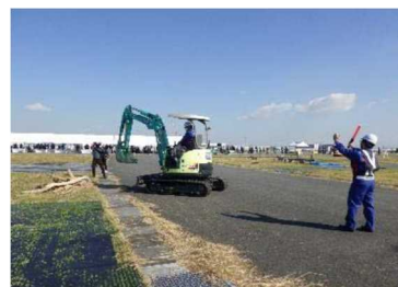
道路啓開訓練
