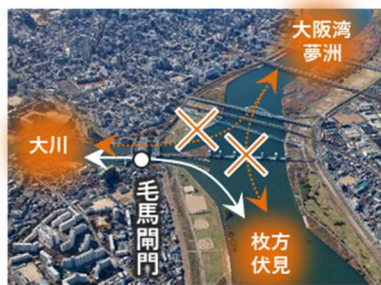
閘門設置前の淀川大堰周辺
