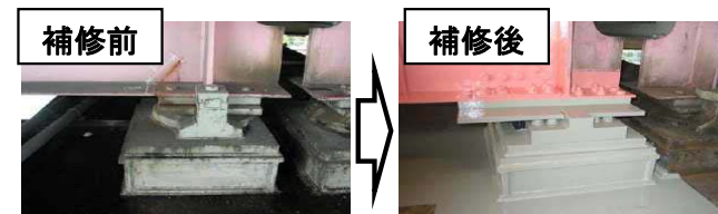
橋梁補修による延命化
