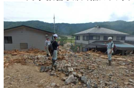
土石流被害状況(丹波市)
