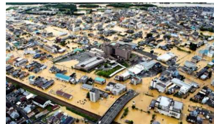
内水被害状況(福知山市)
