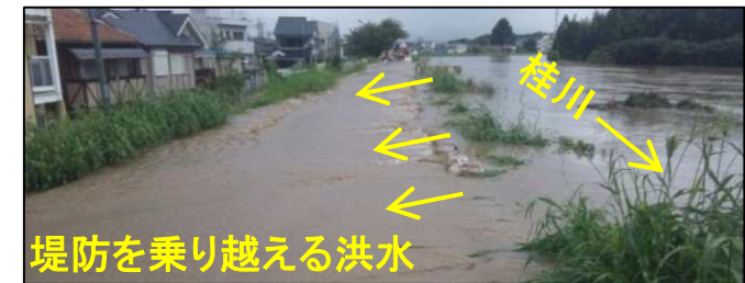
桂川越水状況(渡月橋)
