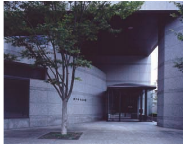
北山通りから見た外観
