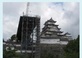
姫路城大天守保存修理
