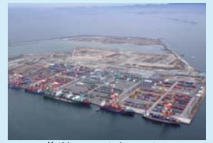
夢洲コンテナターミナル
