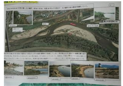
堤防崩壊危機の説明(現状)
