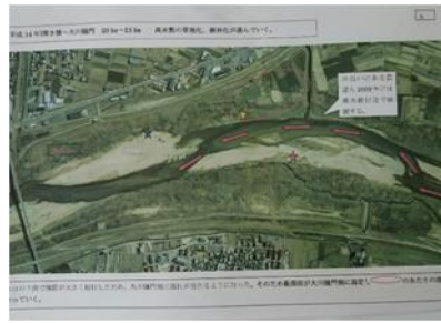
堤防崩壊危機の説明(以前)
