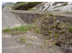
スロープの葛の生育状況
