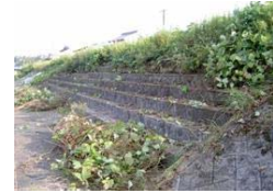
繁茂している葛を除草
