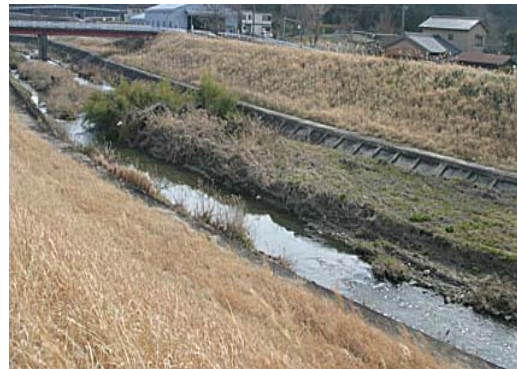
土砂堆積状況(作業中に確認)
