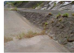
土砂の撤去により、雑草が少量生育 除草の効果あり
