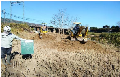
堆積土砂撤去
