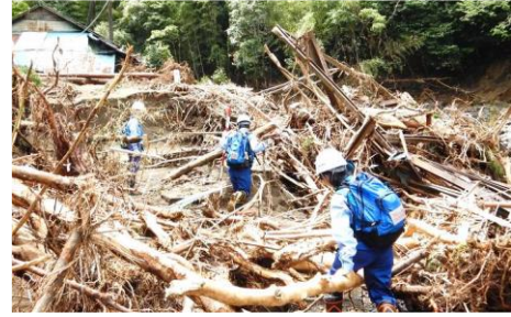
公共土木施設の被害状況の調査
