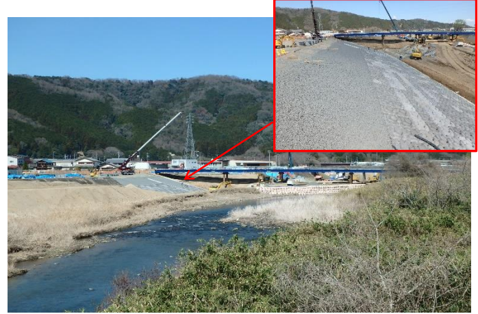
築堤・護岸工事
