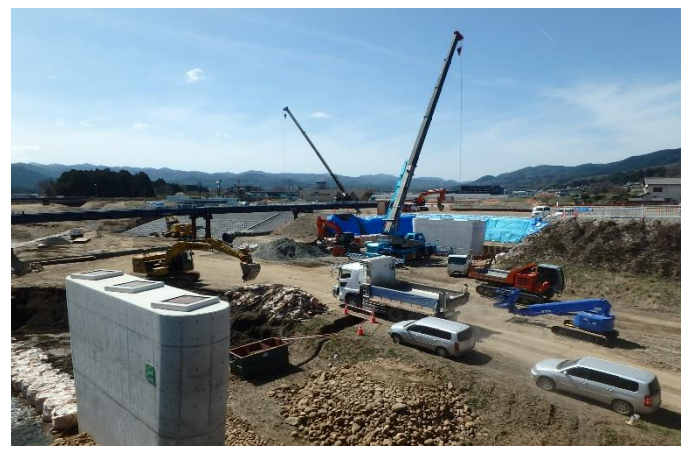
黒田橋架替工事
