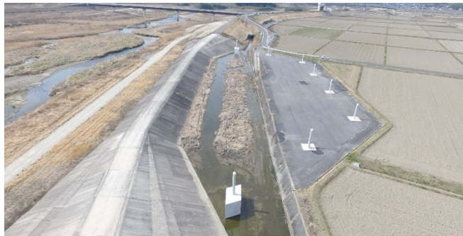
浮遊物流入防止施設
