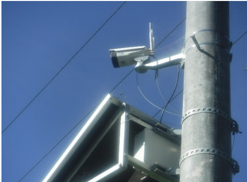
簡易型河川監視カメラ設置状況
