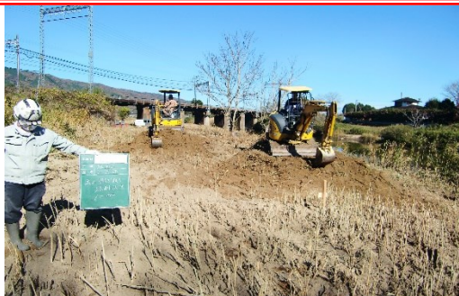
堆積土砂撤去
