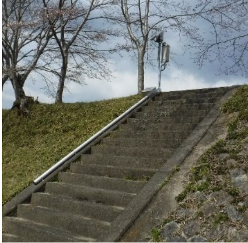
危機管理型水位計設置状況
