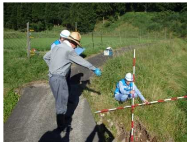
住民との被災状況確認 (平成30年7月西日本豪雨)
