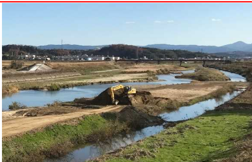
堆積土砂撤去
