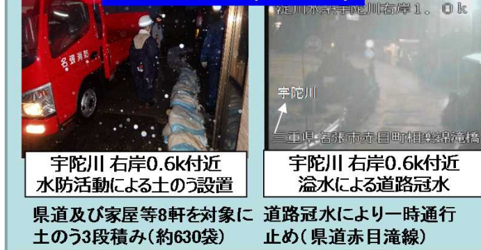
迅速な水防活動(土のう積み)
