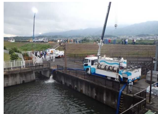
排水ポンプ車による排水訓練
