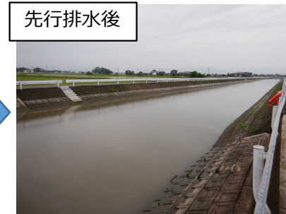
農業水利施設の整備・有効活用(クリークの利用) 【筑後川水系】
