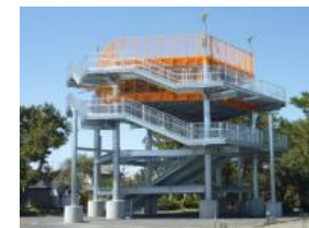
津波避難タワー
