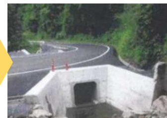
予防措置: 暗渠工の設置
