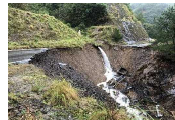
災害に備えた林道の改良整備
