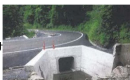
排水工の設置
