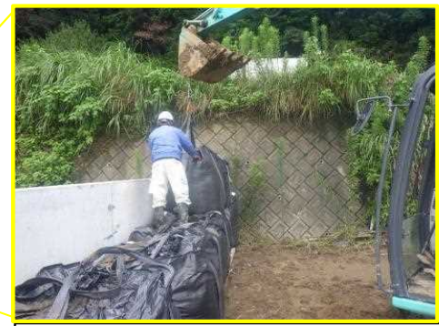
大型土のうによる仮設導流堤工事を実施中。
