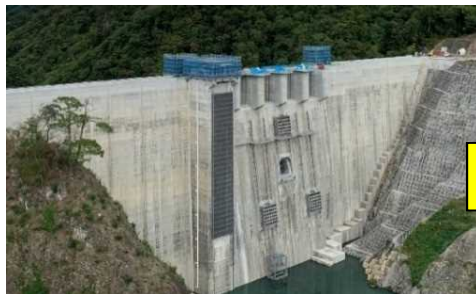
10月11日 状況写真
