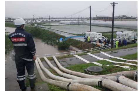
排水活動状況(福岡県久留米市)
