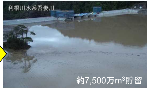
10月15日 17:00 状況写真
