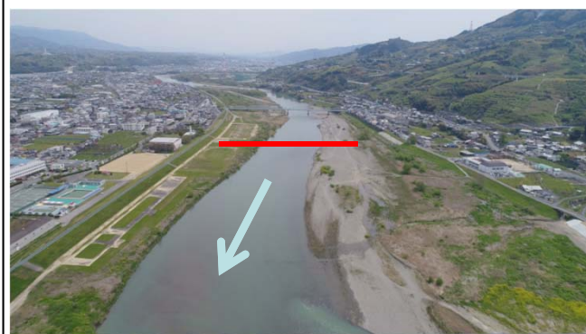
三谷水位観測所 断面位置
