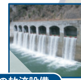
カスケード 計画水位維持放流設備
