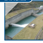
利水放流設備
