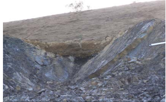
2方向の流れ盤の節理面の組み合わせで崩壊
