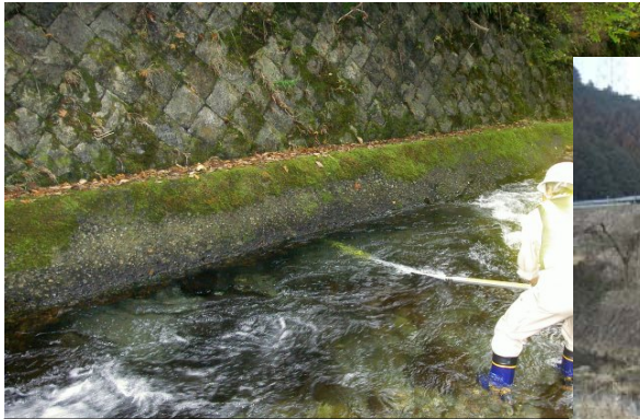
さぐり棒にて擁壁直下地盤の浸食を確認
