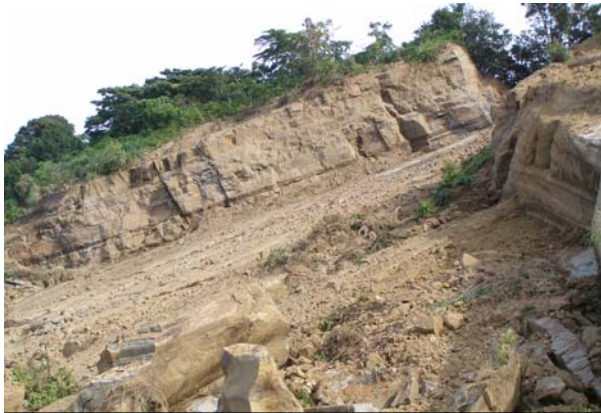
流れ盤の層理面と鉛直の節理面の組み合わせで崩壊
