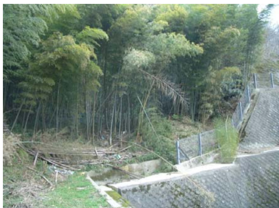
切土脇は竹林の沢地形で表流水が認められる。表流水は、擁壁頭部の集水樹で集められ、擁壁頭部の縦断方向の水路へ流される。 「集水地形→Y」, 「竹林→Y」
