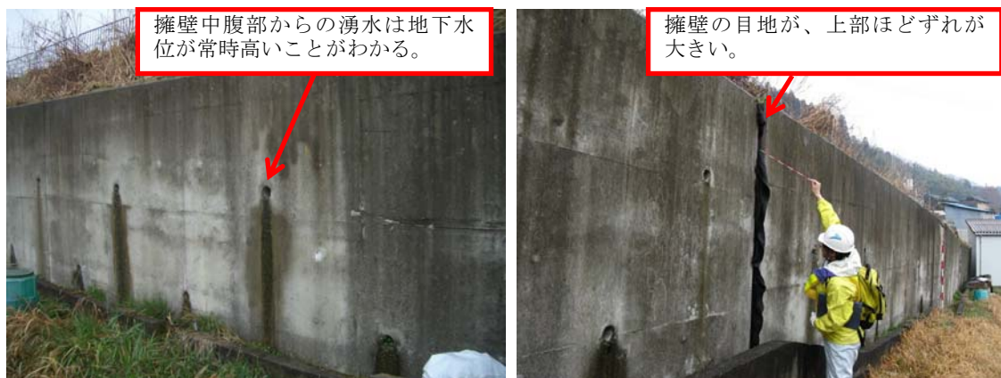
常時湧水が認められる擁壁。土圧がかかるためか手前に傾倒している。
