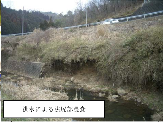
さぐり棒にて擁壁直下地盤の浸食を確認
