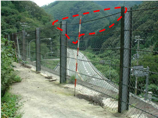
落石防護網の欠落
