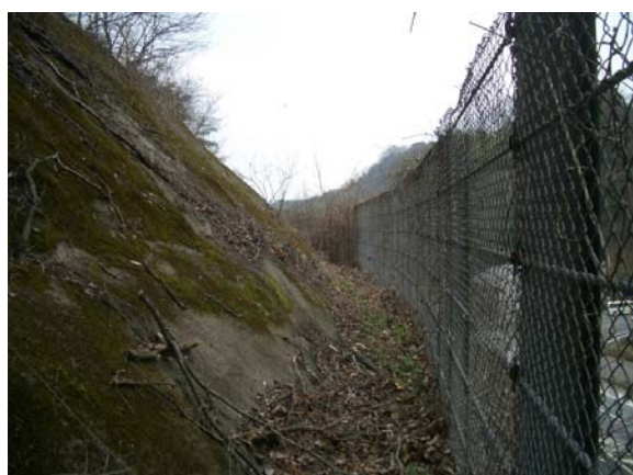
落石防護柵は、ポケット部に落ち葉の堆積や少量の落石の堆積が認められるが、その機能を低下させるほどではない。また、損傷や錆も認められない。
