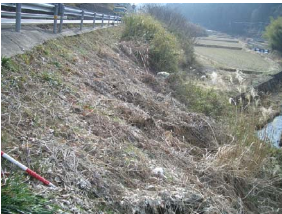
盛土法面は植生が繁茂しており、亀裂などの変位を確認しにくい。はらみ出し等の変位は特に認められない。
