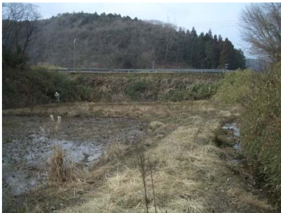
盛土は、沢地形を横断する両盛土区間と、切土法面が反対側車線に位置する片切片盛区間の両方からなる。沢地形は、すなわち集水地形であり、表流水が盛土方向に集まる地形である。 「集水地形→Y」, 「谷地形→Y」
