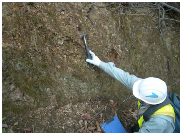
切土法面の直ぐ脇に露頭がある。古生層の堆積岩であるが土砂状に近い状態に風化している。流れ盤でないことを確認した。 「強風化→Y」, 「流れ盤→N」
