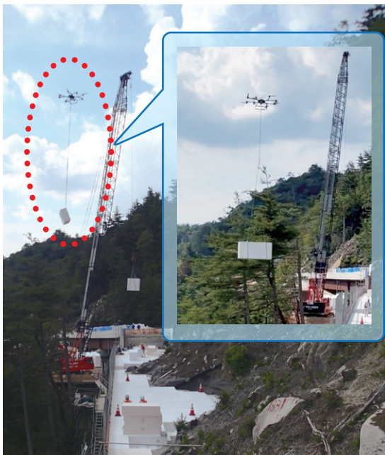
大型ドローンによる運搬状況
