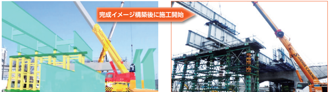
MR 投影状況と施工状況
