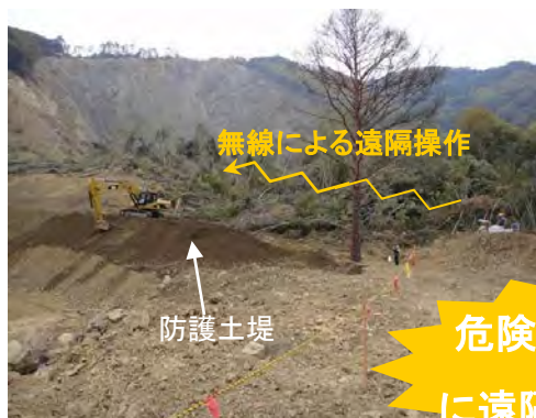
遠隔操作による防護土堤造成
