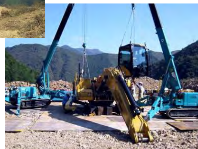
災害現場組立状況
