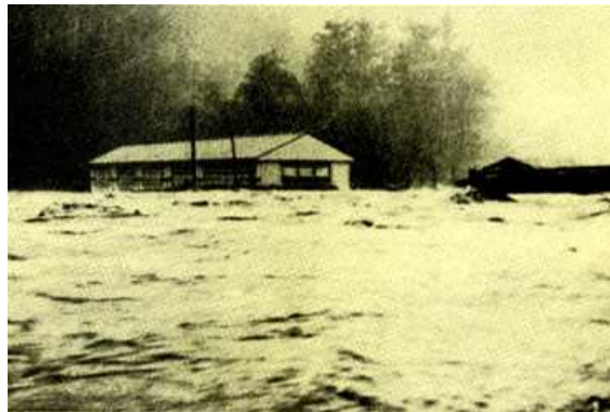
熊野川町の浸水状況
