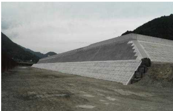
図－2.3 相野谷川輪中堤（高岡地区）
