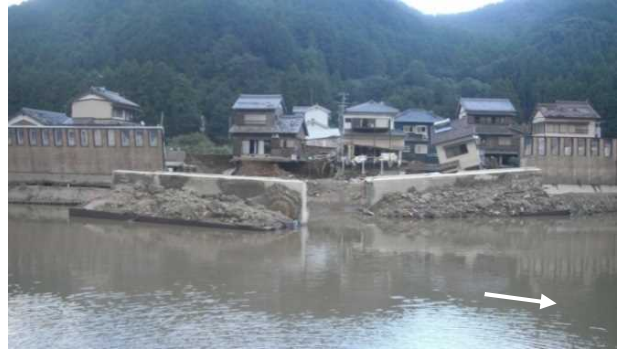
図-1.32 平成23年9月洪水の相野谷川氾濫状況
