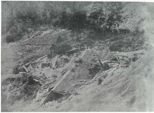
大字小森の山崩れ、家屋崩壊
