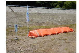
三角水のう工
