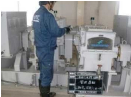
図-12 排水施設の定期点検の状況 （市田川水門）
