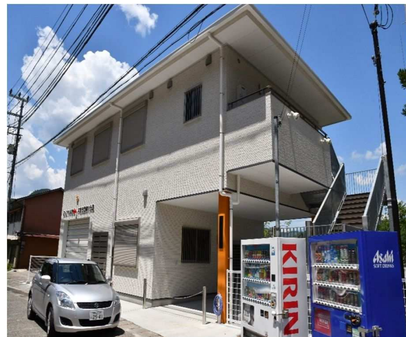
請川地域防災拠点施設
