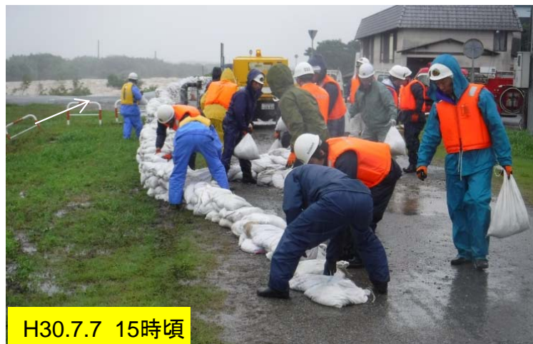
積み土のう工実施状況
