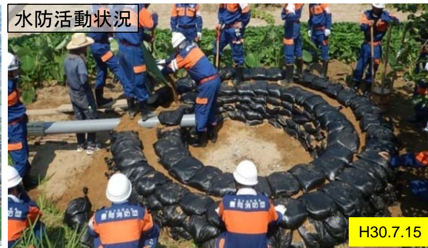
釜段工完了
