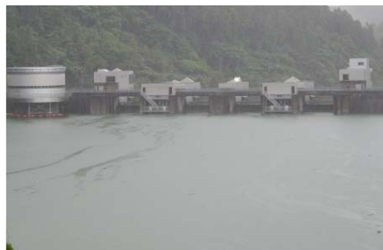
洪水時最高水位に近づく貯水池の状況 (7月5日10時頃)
