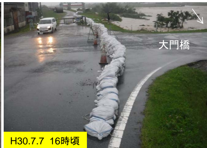
積み土のう工完了
