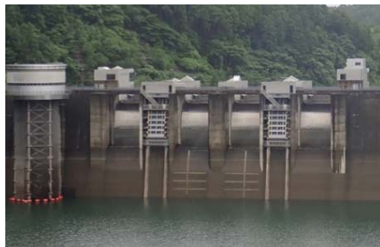
洪水貯留開始直後の貯水池の状況 (7月5日8時頃)
