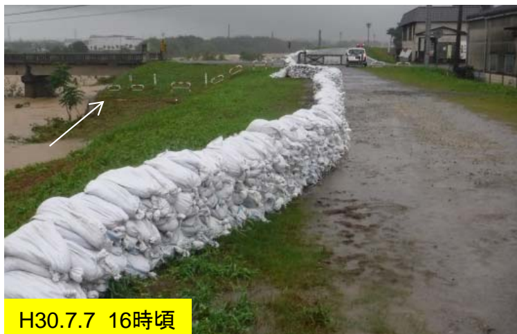
積み土のう工完了
