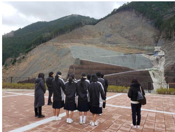
紀伊半島大水害被災箇所 見学学習の様子(大塔町宇井・清水地区)
