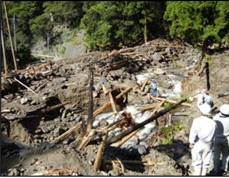
川岸から国道425号線を望む
