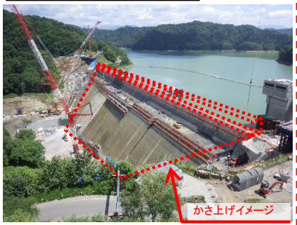
ダム建設・ダム再生
