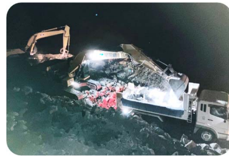
写真② 江田地区での夜間施工 (掘削土の搬出)
