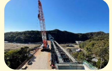
⑦ くしもとちようにしきにしがわばし 串本町二色(二色川橋)
