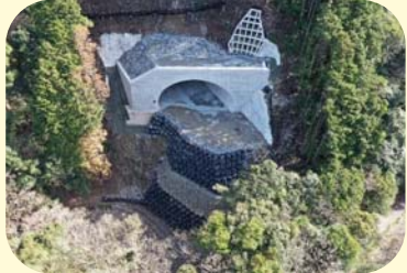
① ちようえすみ えすみ だいに すさみ町江住(江住第二トンネル)
