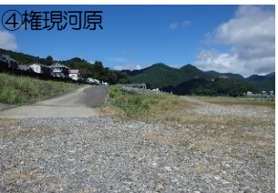
④権現河原 ■紀伊半島大水害での被害を受けて整備した相筋地区の堤防をご視察頂きました。
