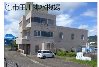
①市田川排水機場 ■熊野川本川と市田川の合流状況や河口砂州の状況をご視察頂きました。
