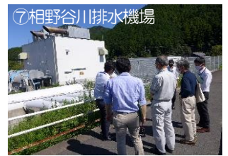
⑦相野谷川排水機場 ■熊野川本川と相野谷川の合流状況や相野谷川排水機場をご視察頂きました。
