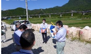
■日足地区での堤防整備状況をご視察頂きました。
