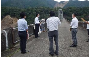
■風屋ダムの貯水池や堤体、表面取水設備をご視察頂きました。
