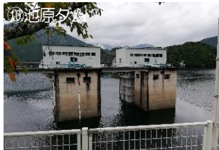
■池原ダムの貯水池、表面取水設備をご視察頂きました。
