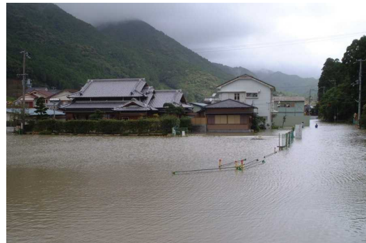
紀宝町（高岡地区）浸水状況
