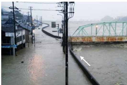
紀宝町（成川地区）の浸水状況
