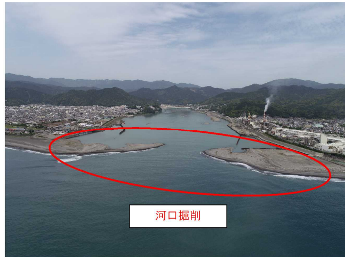
図-4.3 河口砂州掘削
